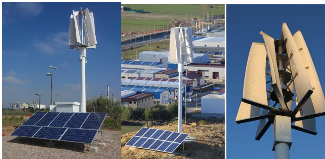
Слика 4- Хибридни систем (сунце-ветар) фирме TODENSOLAR базиран на интеграцији соларних панела и вертикалне турбине Kliux Geo [14]
