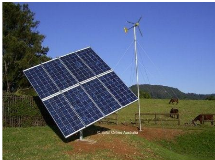
Слика 1- Хибридни систем (сунце-ветар) снаге 1kW производње фирме SOLAR ONLINE[11]
