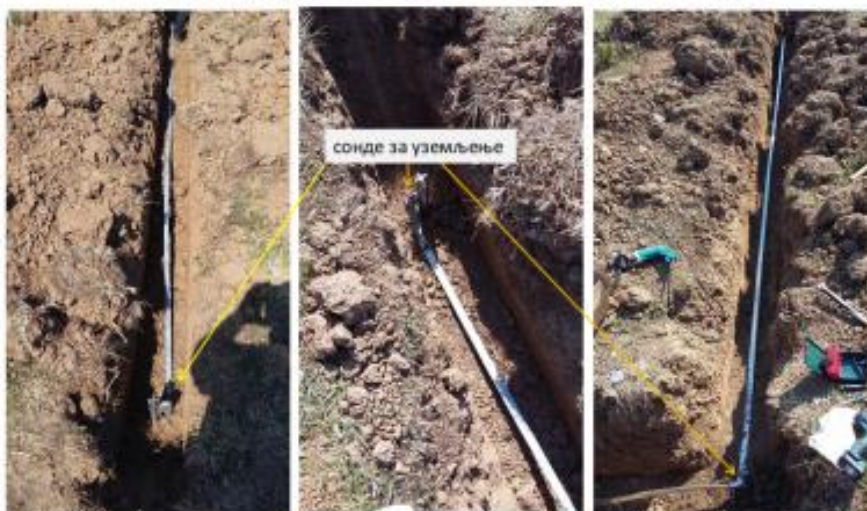
Линијски уземљивач: 3 сонде од 1.5м на растојању од око 6м; поцинкована челична трака FeZn 25x4 укупне дужине од око 20м; тло комбинација глине и песка; Ruzs10Q
