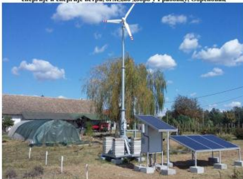
Слика 2. Хибридни систем снабдевања енергијом когенерацијом сунчеве и енергије ветра, огледно добро у Грабовцу, Обреновац
