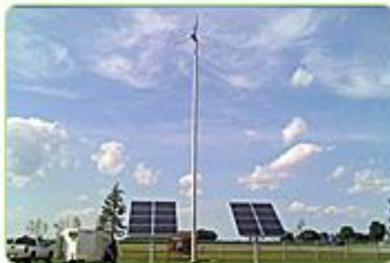
Слика 2- Хибридни систем (сунце-ветар) снаге 2kW производње фирме AGRICULTURE SOLAR[12]
