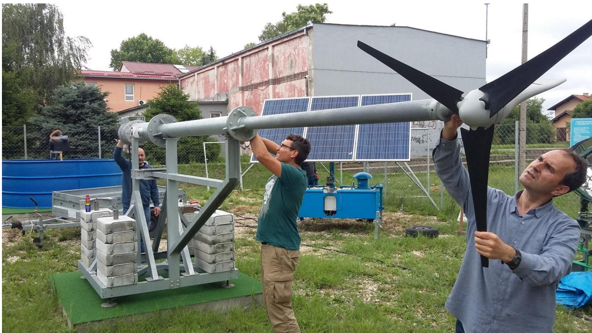
Слика 11. Ветротурбина са преклопним сегментираним стубом типа „старински ђерам“ који омогућава лак приступ ветротурбини и погодност за учење и обуку.
